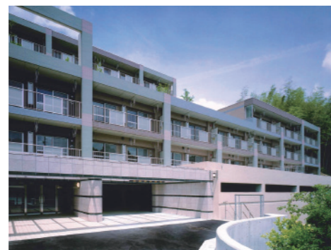
新作Iマンション・竣工(2007年)時
