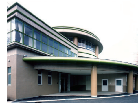
井田小学校・竣工(1996年)時
