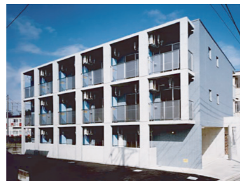
宮内Hマンション・竣工(2003年)時
