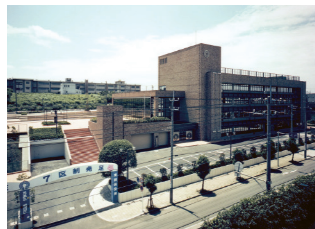
宮前区役所・竣工(1980年)時
