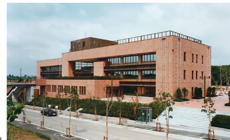
麻生区役所・竣工(1980年)時
